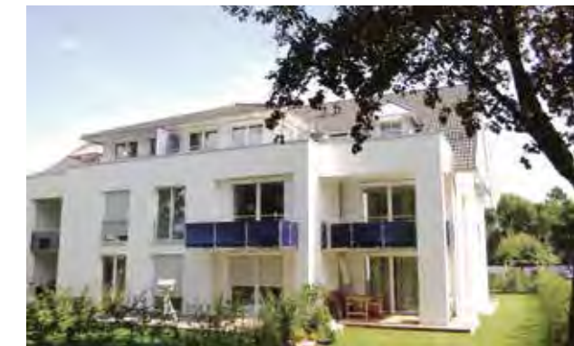
München-Maxhof: „Wohnen am Forstenrieder Park“ 10 Wohnungen
